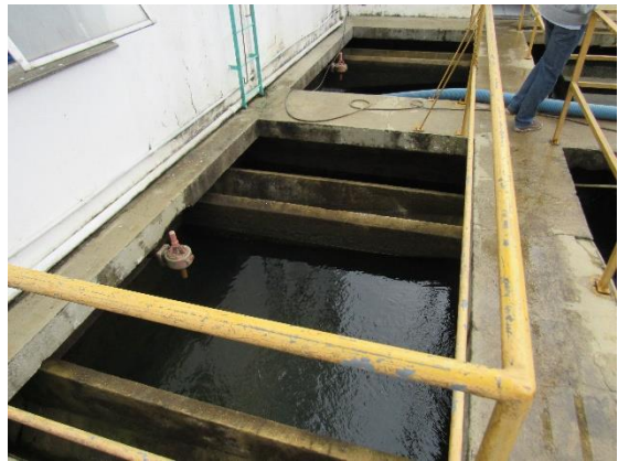
Filtros módulo metálico e filtros módulo em concreto
