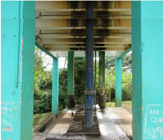
Bombas de Eixo Vertical
