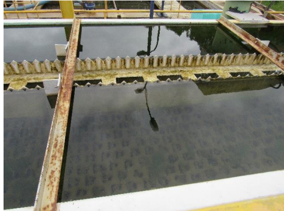
Floculadores e Decantadores do módulo metálico
