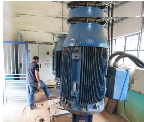
Bombas de Eixo Vertical
