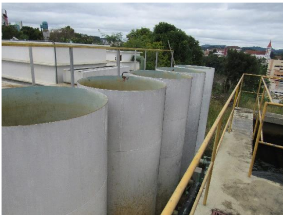
Filtros módulo metálico e filtros módulo em concreto
