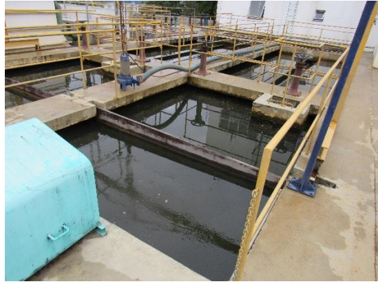
Entrada de Água e Floculadores do módulo em Concreto
