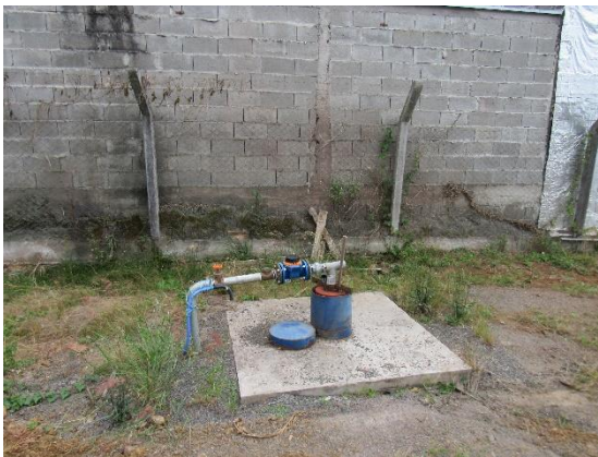
Poço Parque da Uva e dosador de Cloro e Flúor
