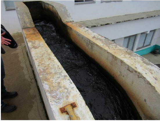
Entrada de Água e Floculadores do módulo em Concreto
