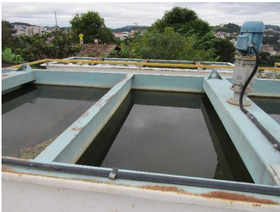
Floculadores e Decantadores do módulo metálico
