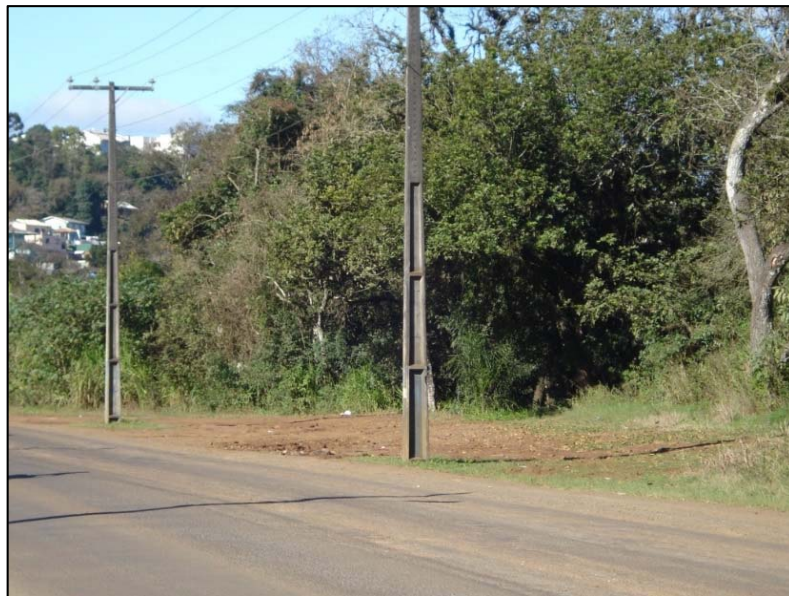
Figura 4 - Local da elevatória EE-09
