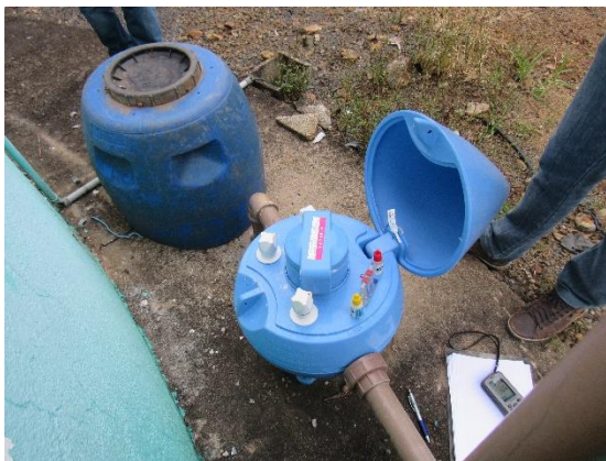
Poço Parque da Uva e dosador de Cloro e Flúor
